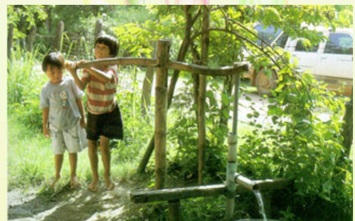
เครื่องสูบน้ำจากบาดาลแบบง่าย ๆ โดยใช้ไม้ไฟ
