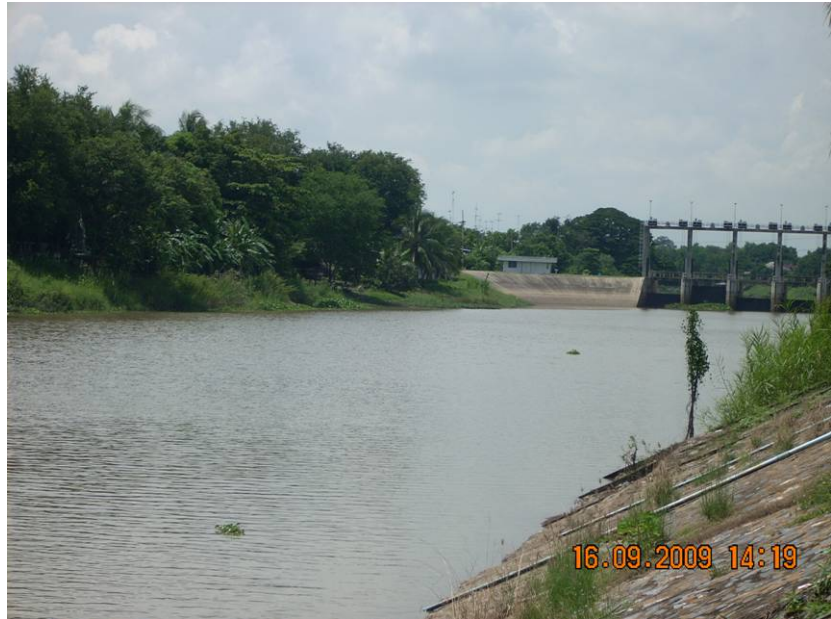
รูปที่ 7 ประดูระบายน้ำบนลำน้ำแม่ น้ำลพบุรี บริเวณบ้านโคกหม้อ
