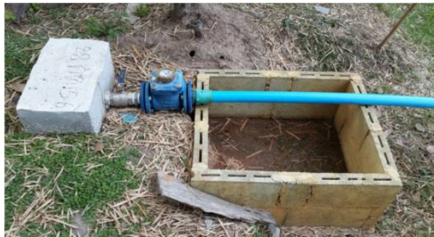
รูปที่ 10 ภาพแสดงลักษณะการเชื่อมต่อและการกักเก็บน้ำบาดาล
