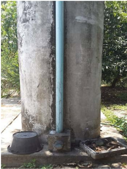
จุดถ่ายตะกอน/ของเสีย ออกจากถังเก็บน้ำ
