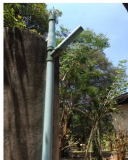
สภาพถังเก็บน้ำ และรางริน
