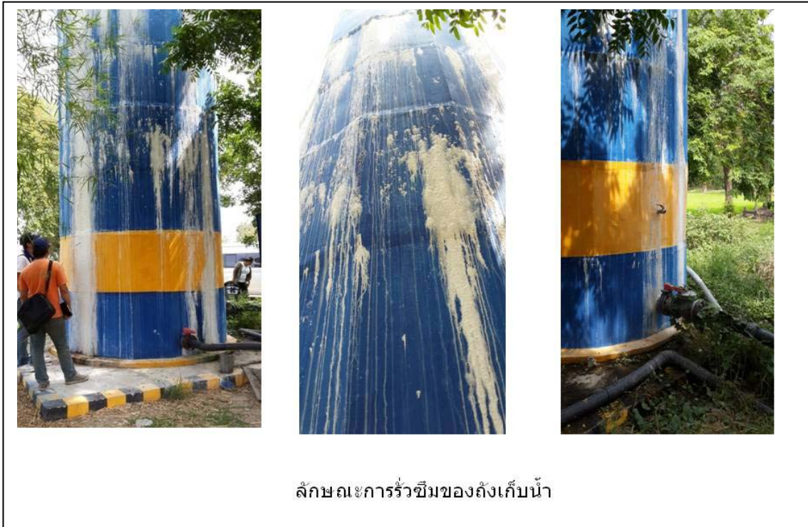
รูปที่ 11 ภาพแสดงลักษณะการรื้อซึมของถังเก็บน้ำบาดาล
