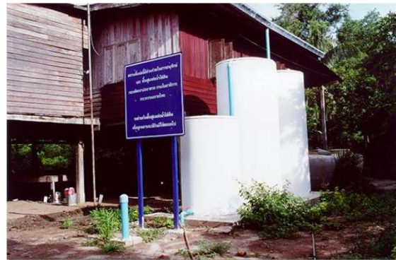
โครงการดำเนินการก่อสร้างเสร็จแล้ว
