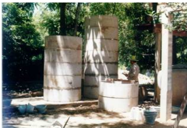
การดำเนินการก่อสร้างถังเก็บน้ำ
