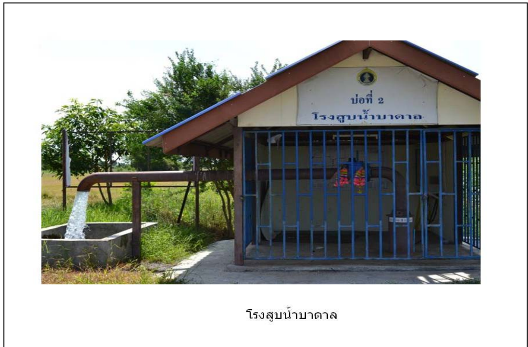
รูปที่ 5 ภาพแสดงโรงอาคารสูบน้ำบาดาล บ่อที่ 2
