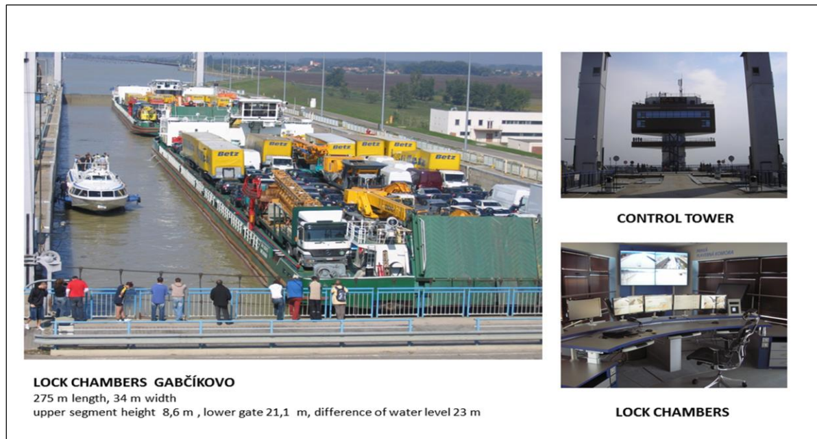
รูปที่ 12 อาคารควบคุมการเดินเรือและช่องทางเดินเรือ เขื่อน Gabčíkovo
