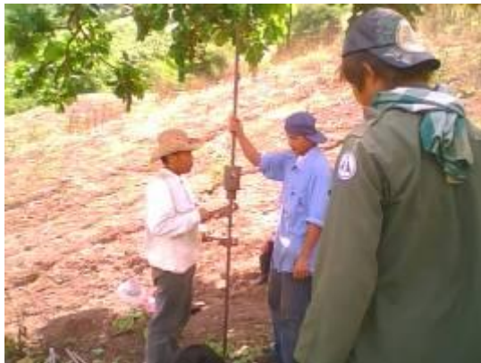
การทดสอบกำลังรับน้ำหนักชั้นดิน
