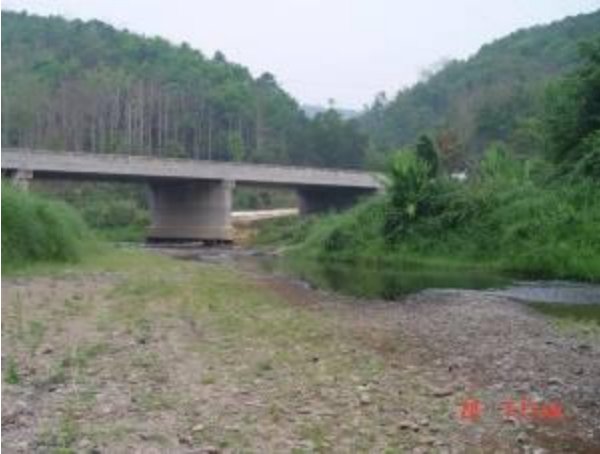
รูปที่ 4.43 สะพานข้ามห้วยน้ำริด บ้านกัวเคียน
