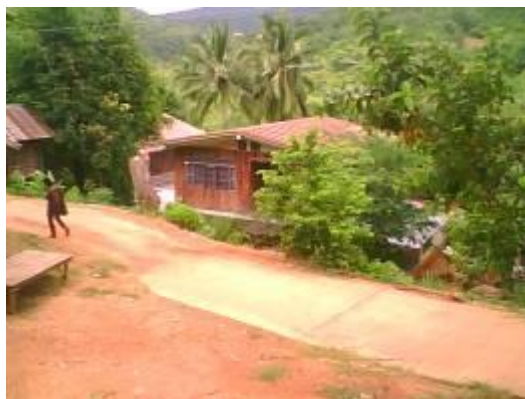
สภาพบ้านเรือนที่ปลูกสร้างโดยการตัดฐานของลาดเขา
