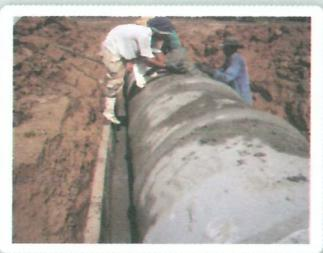
4) การต่อห่อต้องทำตามเอกสารกำกับและจัดวางท่อของบริษัทผู้ผลิตและต้องมีการทดสอบแรงดัน (ในกรณีที่เป็นห่อรับแรงดัน)
