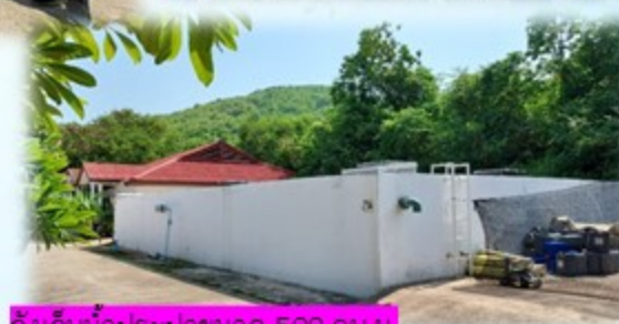
ถังเก็บน้ำประปาขนาด 500 ลบ.ม.
