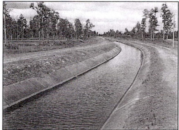
คลองตาดคอนกรีต
