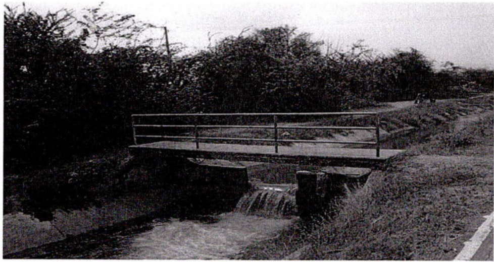
อาคารน้ำตก (Drop Structure)
