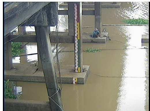
ระดับวิกฤติน้ำแล้ง <15.16 ม.รทก., วิกฤติน้ำท่วม >19.90 ม.รทก. สถานการณ์น้ำ : น้ำแล้งวิกฤติ ระดับน้ำปัจจุบัน = 16.48 ม.รทก.
