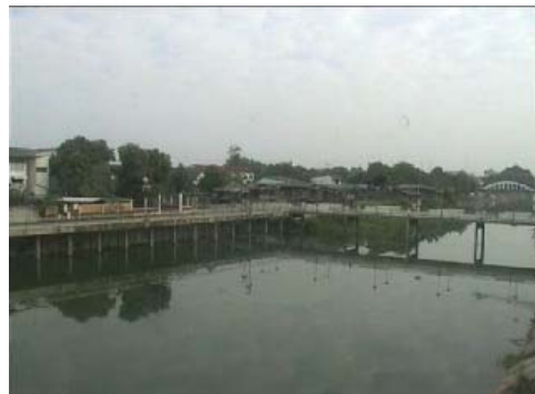
อ.เมือง จ.ลำปาง (ลุ่มน้ำวัง)
