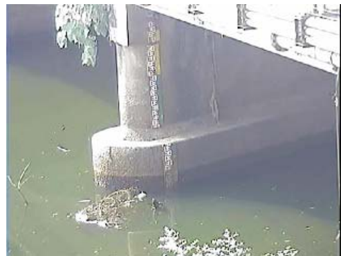
ระดับน้ำปัจจุบัน 0.82 ม.รทก
