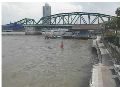
สะพานพุทธ - เขตธนบุรี จ.กรุงเทพฯ (แม่น้ำเจ้าพระยา//ลุ่มน้ำเจ้าพระยา)
