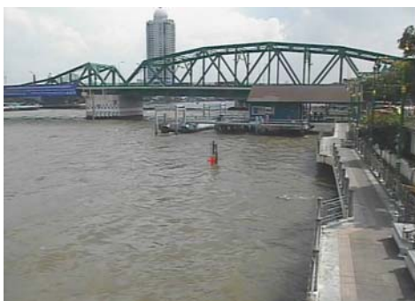
สะพานพุทธ - เขตธนบุรี จ.กรุงเทพฯ (แม่น้ำเจ้าพระยา/ลุ่มน้ำเจ้าพระยา)
