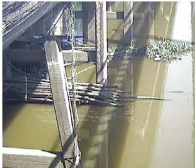
เขิงสะพานบริรักษ์ - อ.เมือง จ.อุทัย (แม่น้ำสะแกกรัง)
