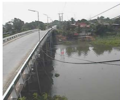
บ้านบางปี - อ.เมือง จ.สพบุรี (ลุ่มน้ำเจ้าพระยา)
