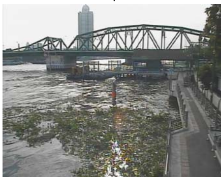
สะพานพุทธ - เขตธนบุรี จ.กรุงเทพฯ (แม่น้ำเจ้าพระยา/ลุ่มน้ำเจ้าพระยา)
