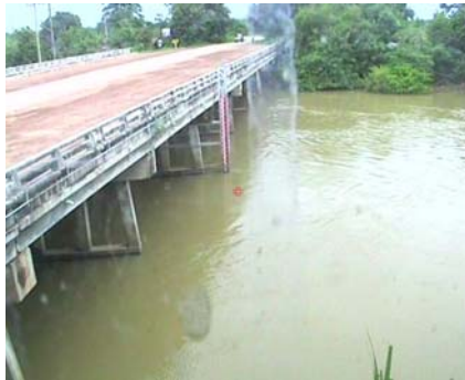
เทศบาลตำบลนาแก - อ.นาแก จ.นครพนม (ห้วยน้ำคำ/ลุ่มน้ำโขงอีสาน)
