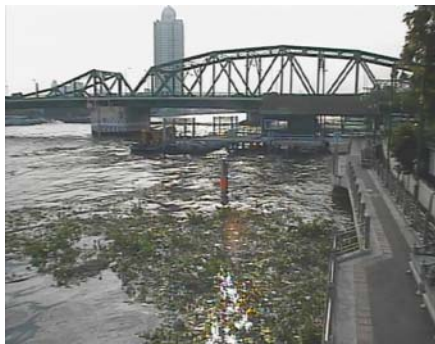
สะพานพุทธ - เขตธนบุรี จ.กรุงเทพฯ (แม่น้ำเจ้าพระยา/ลุ่มน้ำเจ้าพระยา)
