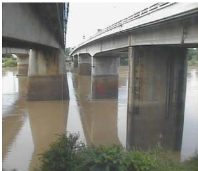
สะพานเดชาดิวงศ์ - อ.เมือง จ.นครสวรรค์ (ลุ่มน้ำเจ้าพระยา)
