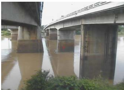
สะพานเดชาดิวงศ์ - อ.เมือง จ.นครสวรรค์ (ลุ่มน้ำเจ้าพระยา)
