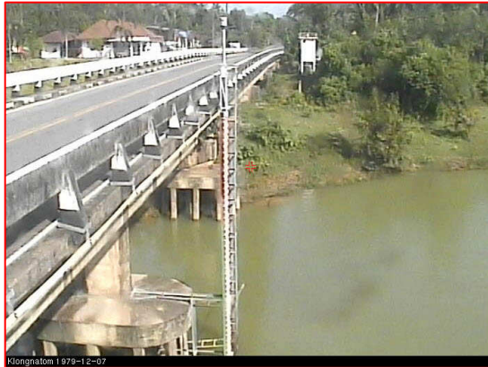
สถานีคลองนาท่อม - อ.ศรีนครินทร์ จ.พัทลุง (ลุ่มน้ำทะเลสาบสงขลา)
