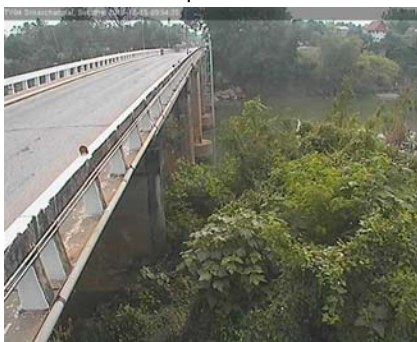
สะพานศรีสัชนาลัย - อ.ศรีสัชนาลัย จ.สุโขทัย (ลุ่มน้ำยม)
