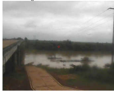
สถานีปากอุ้ม จ.นครพนม (แม่น้ำโขง)
