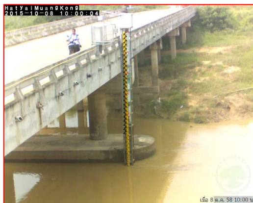
สถานีสะพานวัดม่วงก้อง – ต.พังลา อ.สะเดา จ.สงขลา (ลุ่มน้ำทะเลสาบสงขลา)
