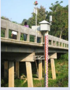
สถานีเตือนภัยด้วย ปริมาณน้ำฝนและระดับน้ำ
