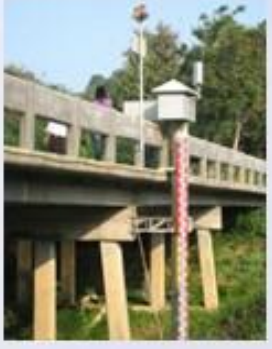
สถานีเตือนภัยด้วย ปรัภณน้ำฝนและระดับน้ำ
